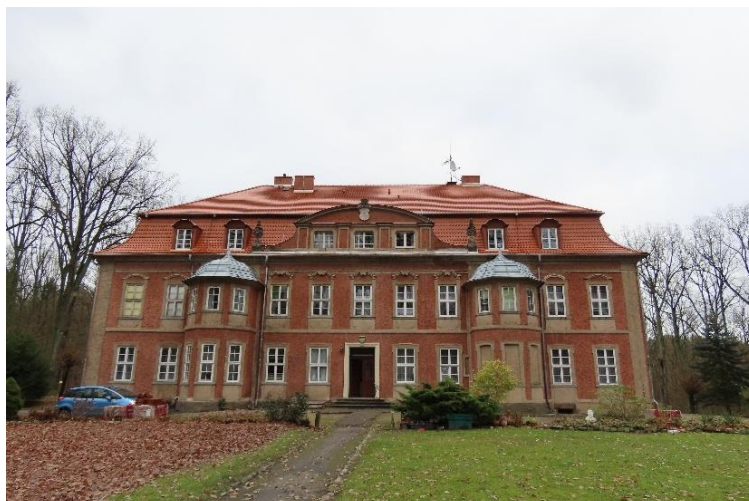
Goraj, gm. Czarnków, budynek mieszkalno-biurowy administracji majątku
